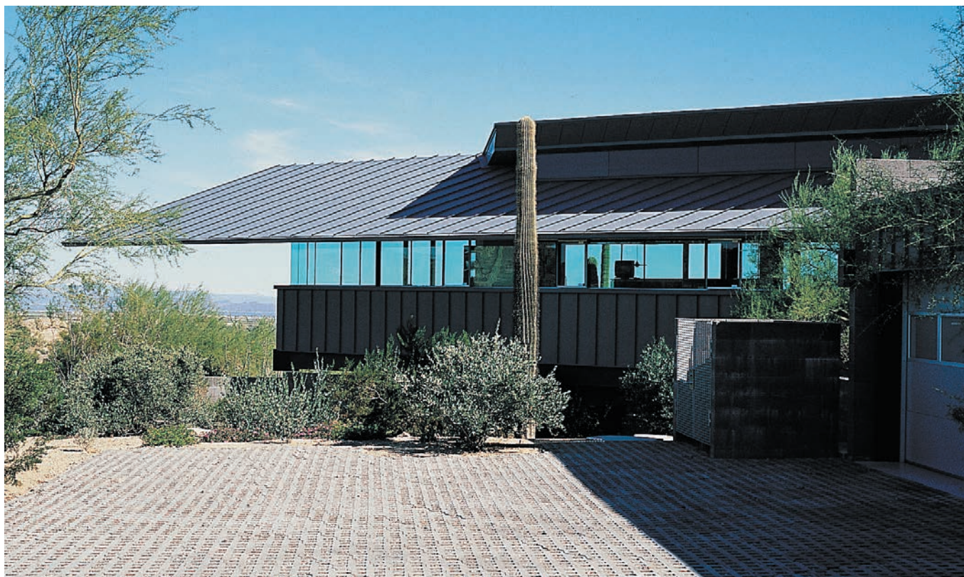
Casa Privata, Scottsdale (USA) - Architetto Eddie Jones Studio Inc. - Entreprise : Kovach Inc.
