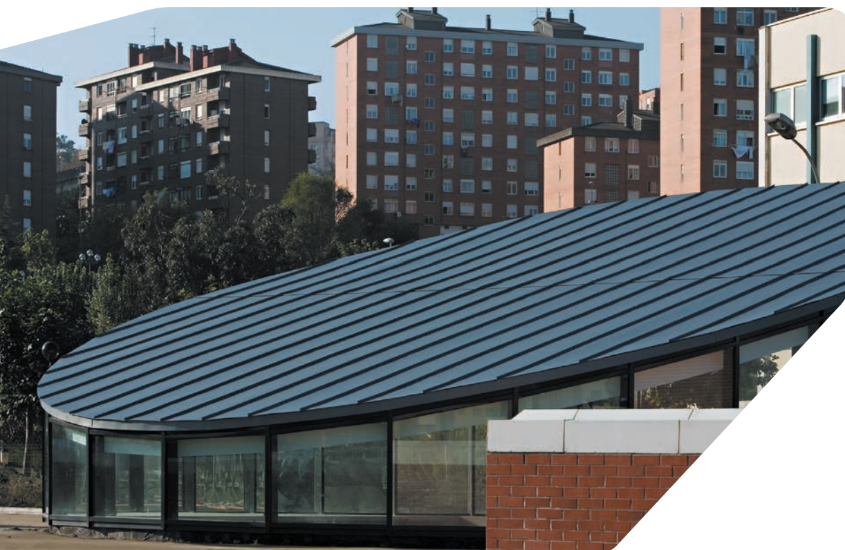
Università di Santander (Espagne) - Architetto : Juan Carlos Ruiz Moncalean - Entreprise : Tesico
