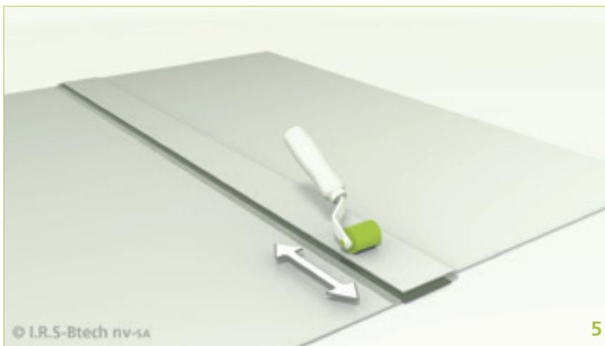
Parachèvement des joints longitudinaux au moyen de SecuOne Pre-tape EPDM
