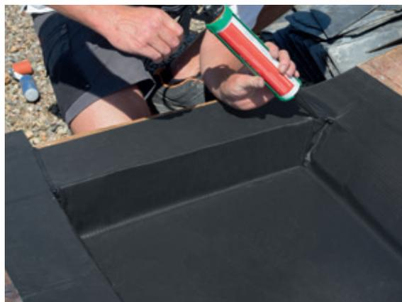
**Recouvrement** La bande supérieure se colle sur la bande inférieure avec un recouvrement de 50 mm. Pour optimiser l'encollage, une pression manuelle doit être exercée sur la partie supérieure et le rouleau de marouflage doit être utilisé.
