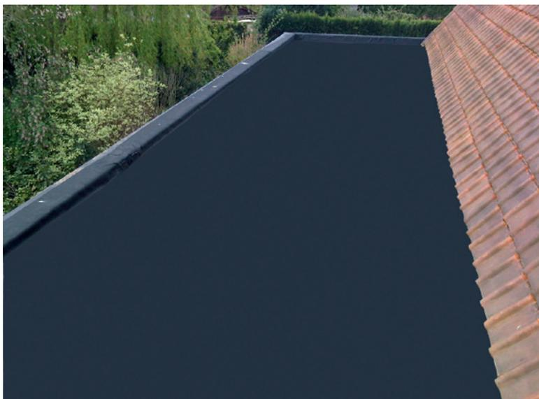
La membrane Maxon EPDM reste élastique, ne nécessite pas d'entretien, est à 100% résistante à l'ozone et aux rayons UV. On peut marcher dessus et elle dispose d'un certificat de récupération de l'eau de pluie.
