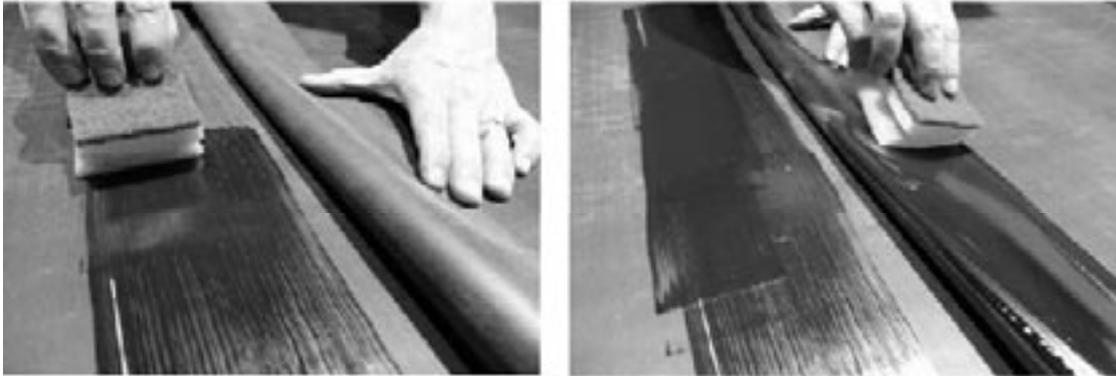
Vérifier le séchage du HP 250 (toucher la surface avec la main et pousser la main vers l'avant pour vérifier le séchage) et appliquer la bande auto-adhésive Secur Tape. Puis rouler.
