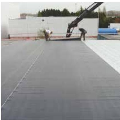
Les bandes sont déroulées et positionnées, repliées sur elles-mêmes en deux sur toute la longueur, les bandes restant bien en place sur le plat du toit. La partie centrale du toit peut être partiellement collée avec la colle Masterpur PX200 appliquée sur le support uniquement avec une consommation de 350 g/m<sup>2</sup> (selon le support) ou 70% d'adhérence.
