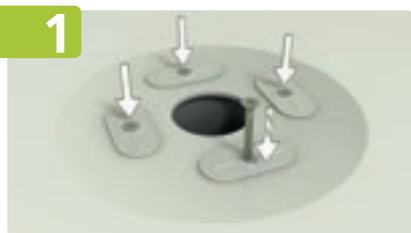
Fixer mécaniquement votre membrane à l'aide de 4 plaquettes de répartition placées autour d'un trou préalablement découpé.
