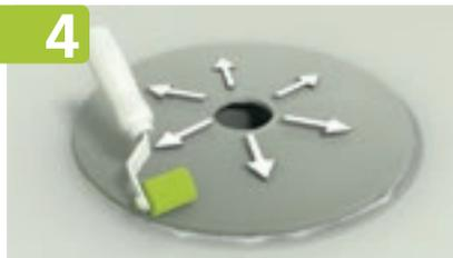
Maroufflez à l'aide d'un rouleau ergonomique de pression de l'intérieur vers l'extérieur de la platine.
