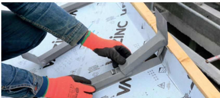
La mise en œuvre de cette toiture en zinc à tasseaux a été assurée par la société CCRT de Villemomble (93). Le traitement des égouts repose sur un système d'entablement par coulisseaux et intègre parfaitement un chéneau encaissé. Les tasseaux marquent avec précision l'intersection entre le toit et la façade en parement de pierre et restent en harmonie avec les sous faces.
