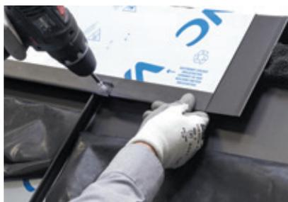
Insérez le capot de faitage dans les clips en laissant un écartement de 5 mm entre deux capots. Vissez le à l'aide d'une vis en inox type SPS 3-7,1-4.5 x 18. Utilisez un bit numéro SR1. Défilez.
