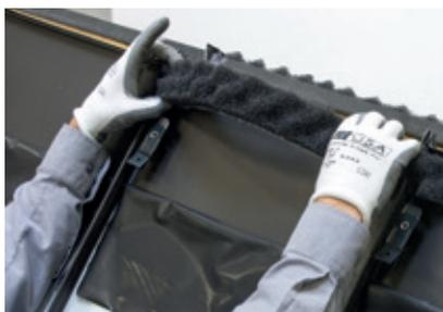
Collez la bande au-dessus des clips à 10 mm min du relevé de tête et sur toute la largeur des bacs + 20 mm.
