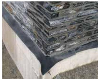
Barrière hydrofuge pour les murs, entourages de cheminées et au-dessus des linteaux
