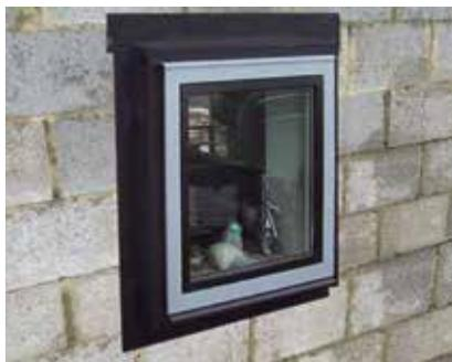
Étanchéité à l'air et à l'eau autour des fenêtres, portes et seuils
