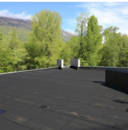
“Des membranes EPDM ont été posées pour la première fois en 1961 sur les toitures de l'aéroport de Chicago aux USA. L'étanchéité est toujours impeccable ! Plus de cinquante ans après sa pose, cet EPDM affiche encore un taux d'élasticité de 250 %.”
