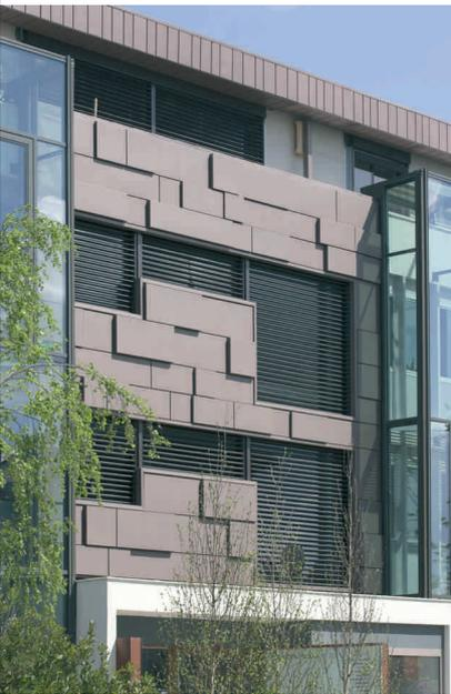
Mit VMZINC® sind verschiedene Kassettensysteme möglich. Durch eine individuelle Fertigung und Anpassung der Kassetten an die Gebäudegeometrie kann eine unverwechselbare Optik erzeugt werden. Unser System MOZAIK® bietet zudem die Möglichkeit mit unterschiedlichen Kassettentiefen in die dritte Dimension zu gehen und Fassaden ganz neu zu strukturieren.
