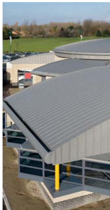
Centrum kulturalne, Graveline (Francja) - Autor projektu: M.Vinson
