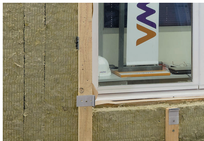
1 - Montaż klipsów uniwersalnych
