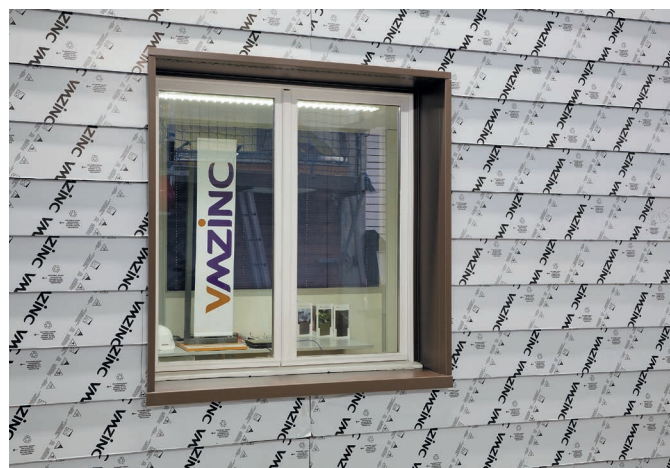
5 - Montaż poszczególnych obróbek wokół okna
