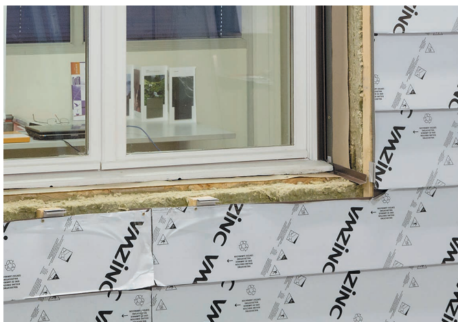
4 - Montaż listew zakańczających i kątowników
