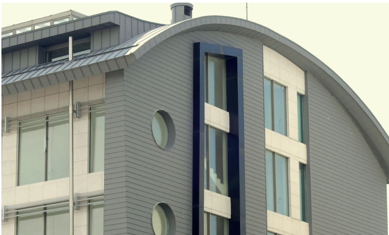
Hotel Akçak, Büyükçekmece, İstanbul (Türkiye) - Architekt: Cavit Sarioglu - Wykonawca: Kayalar Kenet
