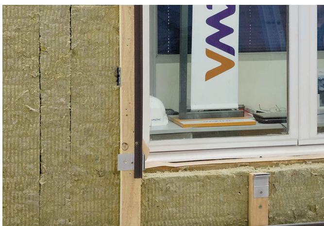
2 - Montaż kątowników równo z klipsami
