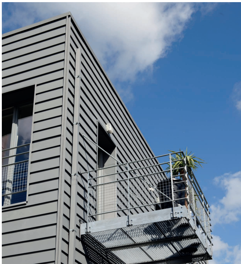
Osiedle, Tournai (Belgia) - Architekt: Meunier-Westrade - Wykonawca: APH CONSTRUCTION
