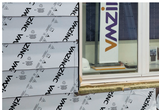
3 - Montaż VMZINC® Overlapping panel
