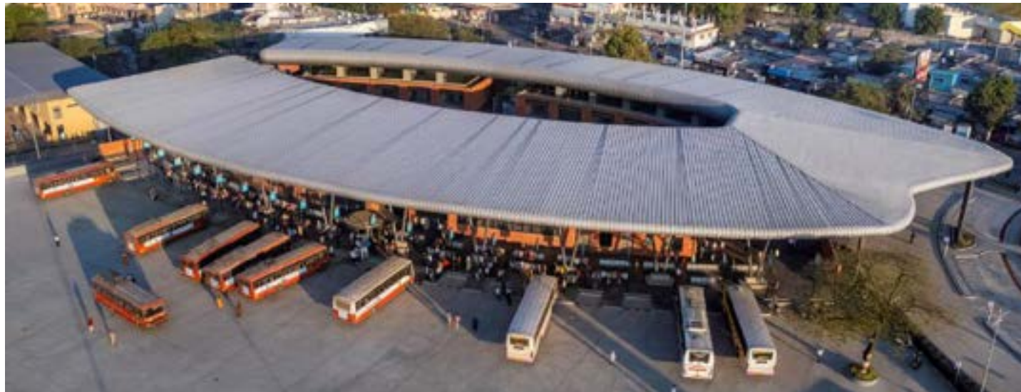
Project : Baramati Busstand | System : VMZINC Standing Seam | Finish : QUARTZ PLUS
