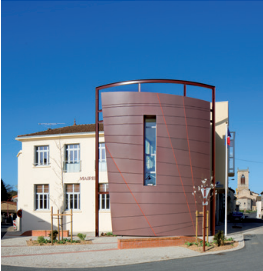
Rathaus, Augerolles (Frankreich) – Architekt: Armando Alvès – Technik: Kassetten in PIGMENTO® rot
