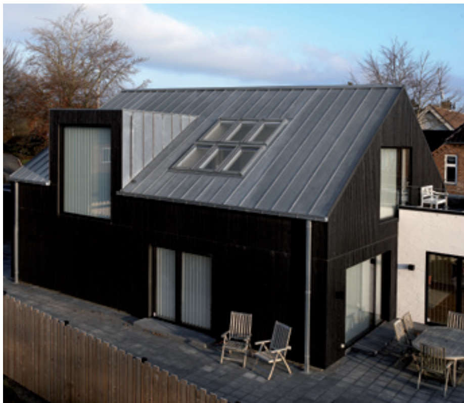
Einfamilienhaus, Silkeborg (Dänemark) – Technik: Stehfalzdeckung in walzblankem VMZINC – Foto: SR Reklame fotografi
