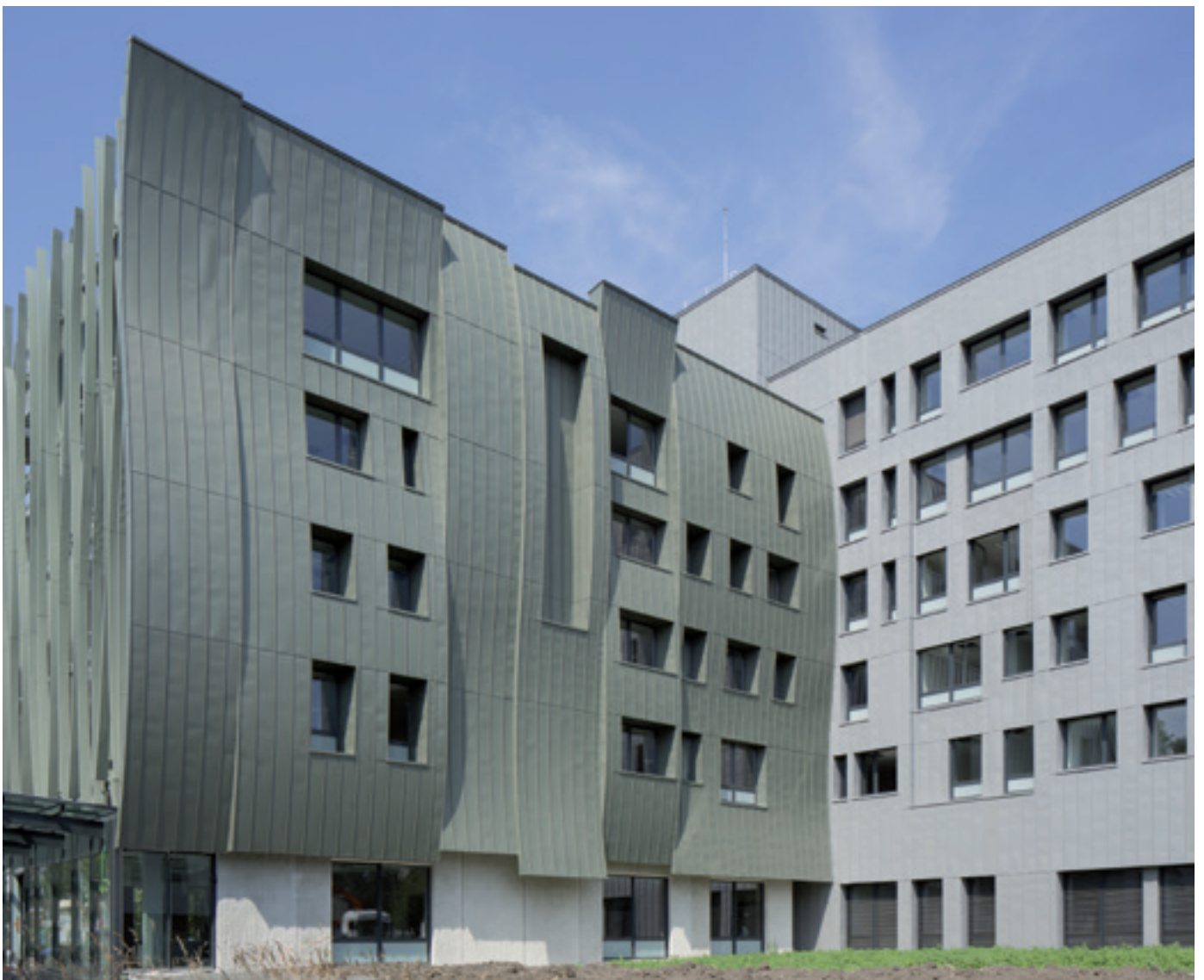
Bureaux Carsat, Clermont-Ferrand (France) - Architect : CRR Architectes - Technik : VMZ Joint debout en QUARTZ-ZINC®, PIGMENTO® vert lichen et PIGMENTO® rouge terre
