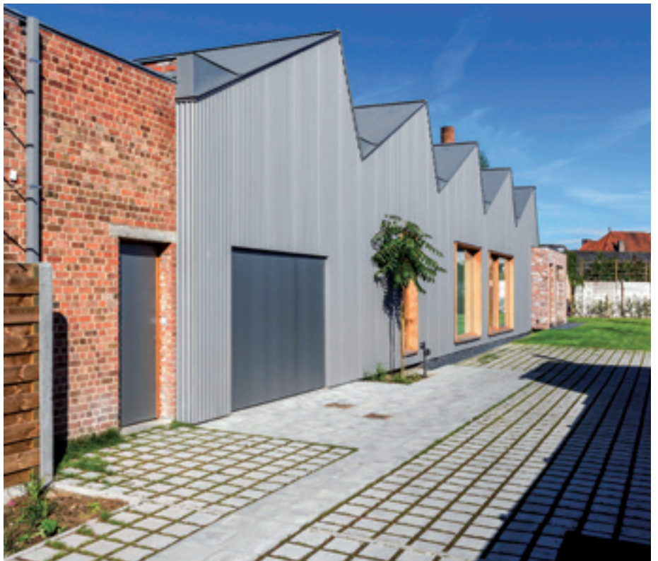
Wohnung und Büro, Kortrijk (Belgien) - Architekt: KLARTE Architecten - Technik: Sinus Profile in QUARTZ-ZINC® - Foto: Jump Picture
