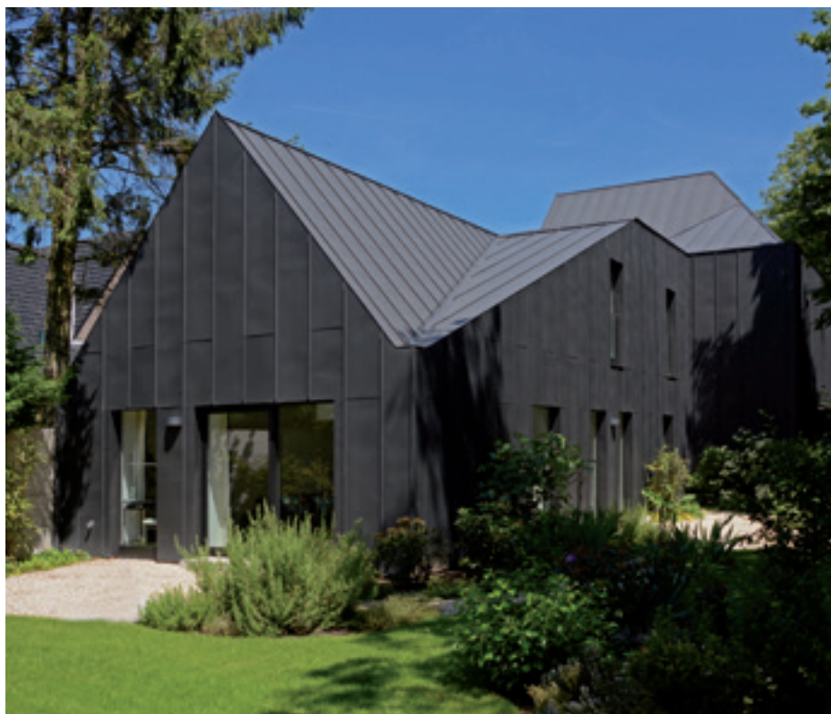
Infamilienhaus, Wondelgem (Belgien) – Architekt: Dirk de Meyer-DDM Architectuur BVBA – Technik: Stehfalzdeckung in ANTHRA-ZINC® – Foto: Jump Picture
