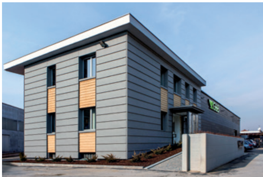
Hauptsitz G&B, Villastellone (Italien) - Architekt: Oscar Battagliotti Architetto - Technik: Stehfalzdeckung in QUARTZ-ZINC® und Steckfalzpaneele in ANTHRA-ZINC® - Foto: Pier Mario Ruggeri
