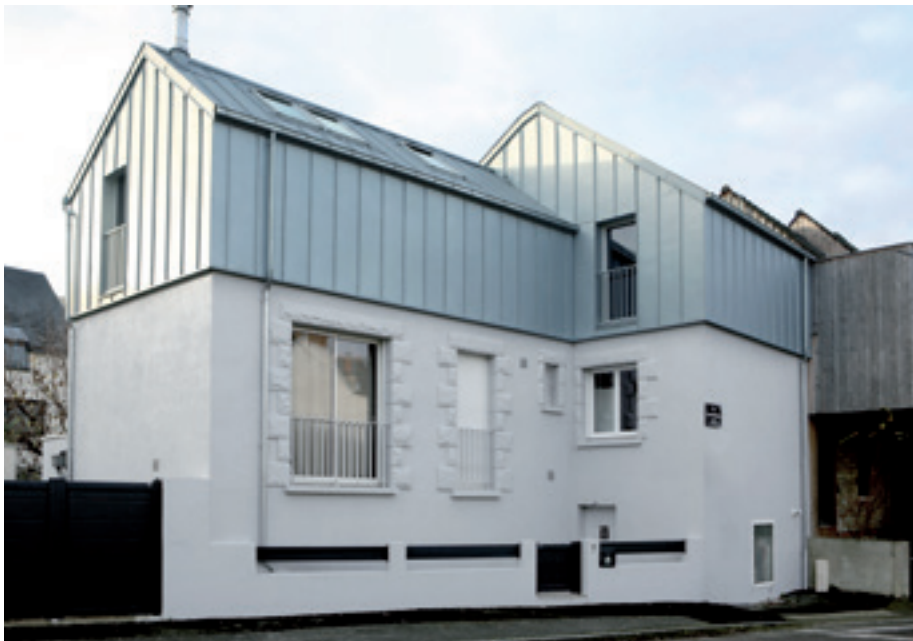
Einfamilienhaus, Rennes (Frankreich) – Architekt: in[side]out – Technik: Stehfalzdeckung in AZENGAR®
