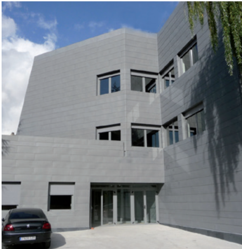
Schule der ITSS (Arbeits- und Sozialversicherungsinspektion), Madrid (Spanien) - Architekt: Luis Arranz Technik: Flatlock Profil in QUARTZ-ZINC® - Fotos: Antonio Ramos
