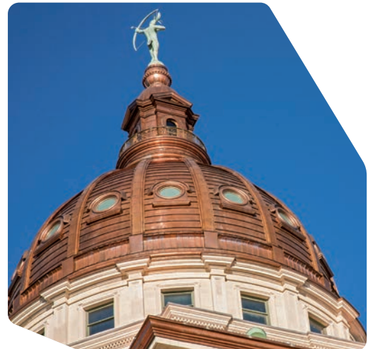
Renovierung des Kansas State Capitol (USA)
