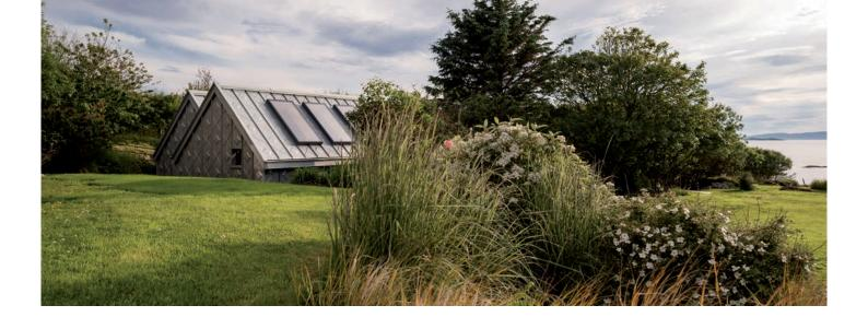
bekannt ist, existierende Systeme bestens an den spezifischen Bedarf eines Architekten anzupassen. "Für dieses Gebäude mit Giebeldach wählten wir das bekannte System der Stehfalzdeckung», erklärt Sammy Baron, Customer Support Manager Ornamentik bei VMZINC®.
