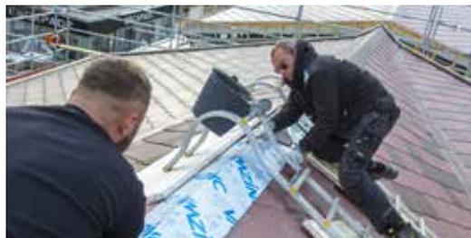
expérience de pose des écaïlles ADEKA® qui, une fois le traçage bien préparé, se sont avérées simples à mettre en œuvre. Elles sont légères à la manutention (12 kg au m<sup>2</sup>) quand d'autres, en ardoise notamment, font de 35 à 40 kg par m<sup>2</sup>.
