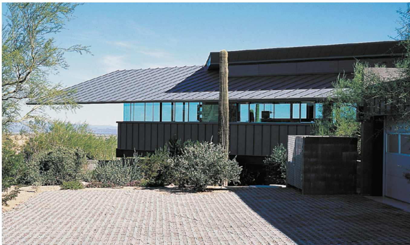
Maison privée, Scottsdale (USA) - Architecte : Eddie Jones Studio Inc. - Entreprise : Kovach Inc.
