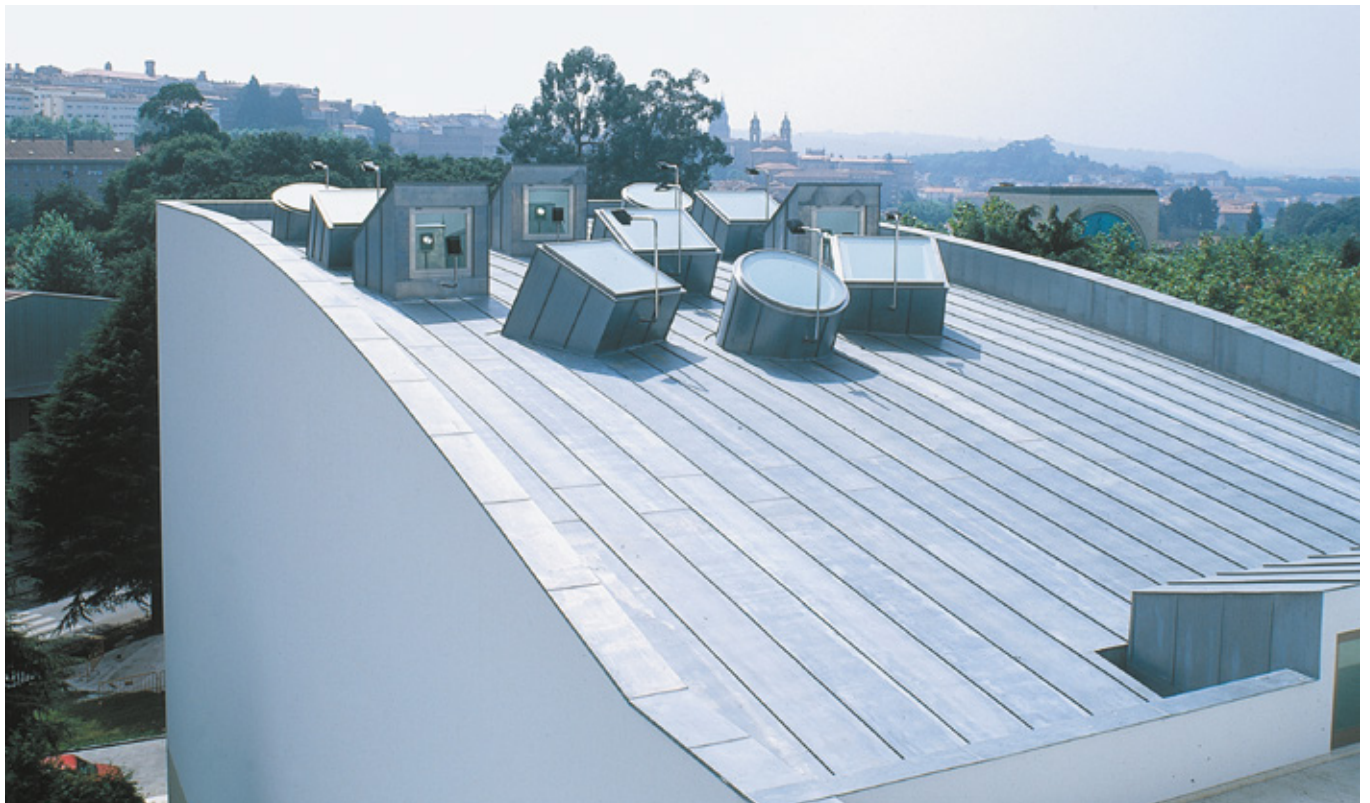
Université, Saint-Jacques de Compostelle (Espagne) - Architecte : Alvaro Siza - Entreprise : RENDAL S.L.
