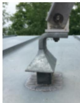
Potelet traversant le support volige ancré dans la structure
