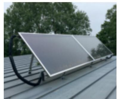
Les panneaux solaires sont fixés sur des rails ou des équerres en U, qui sont vissés sur des potelets ancrés dans la charpente de la couverture. La quantité de potelet et leurs dimensions sont de la responsabilité de l'entreprise ou du bureau d'études associé au projet et sont définies en fonction des charges des panneaux solaires et des charges climatiques.
