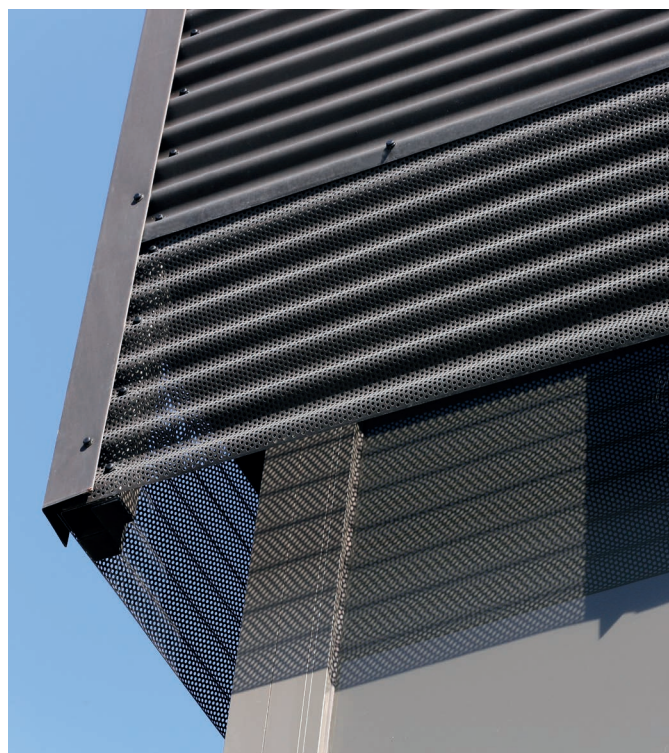
Bureau le ZN, Rennes (France) - Architecte : Meignan Jean Pierre - Entreprise : Payou
