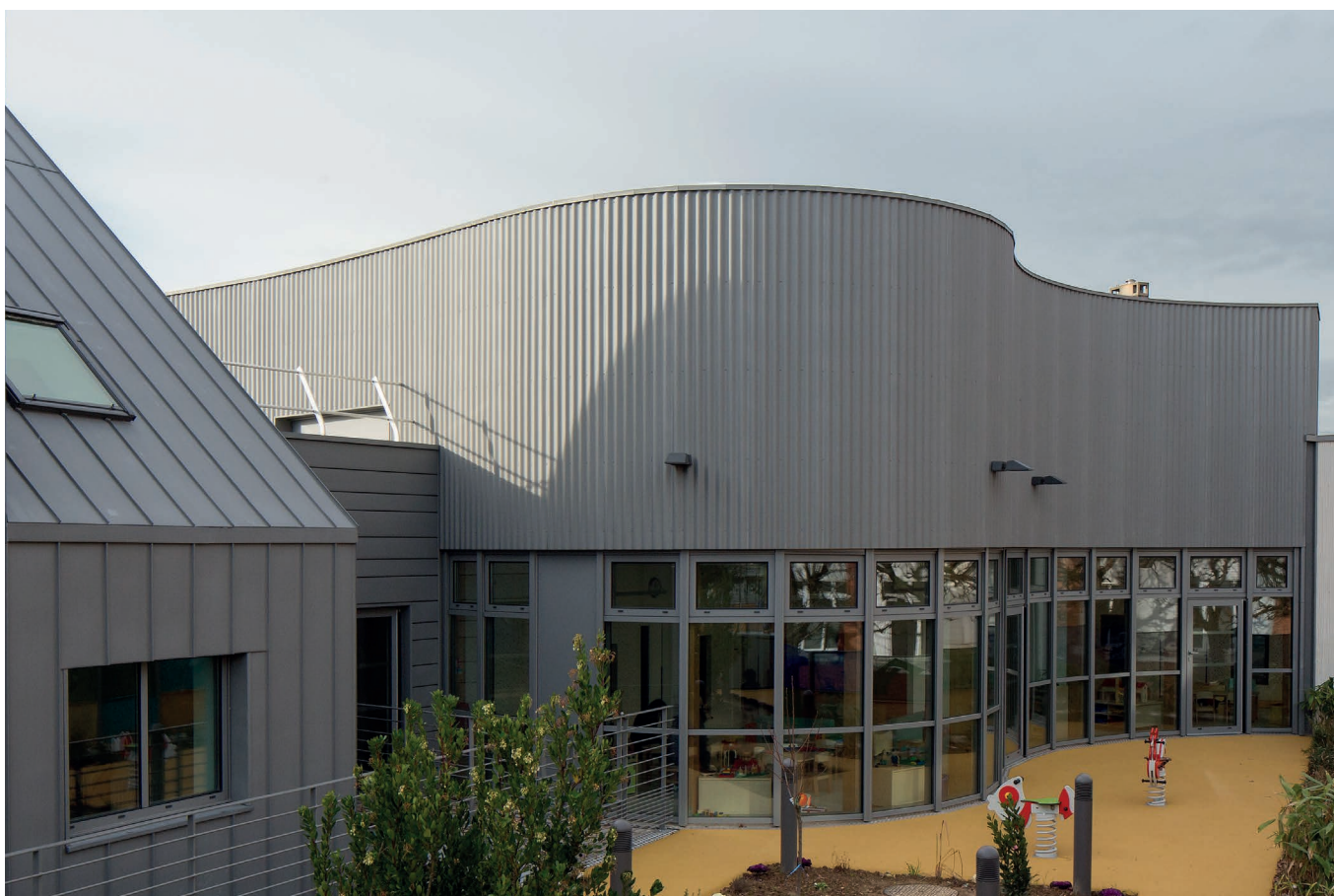
Pôle petite enfance/ Paray Vieille Poste (France) - Architecte : Bigeault Taieb - Entreprise : REPISOL
