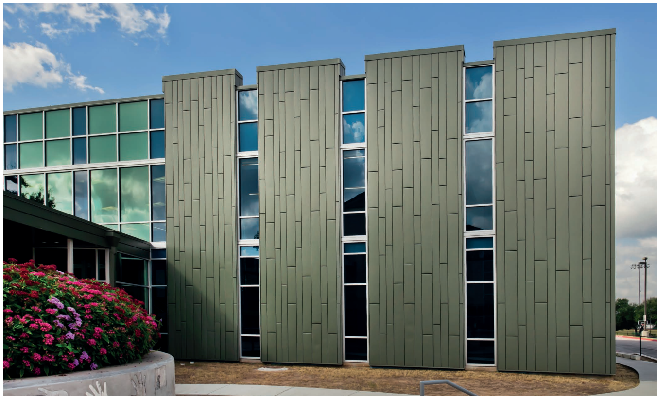
St. Gabriel Catholic School, Austin, Texas (USA) - Architecte : SHW Group - Entreprise : Port Enterprises
