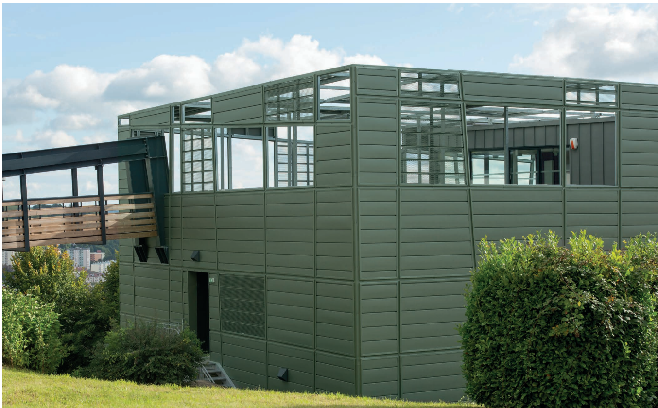
IUT, Aurillac (France) - Architecte : Trinh et Laudat Entreprise : Sacan
