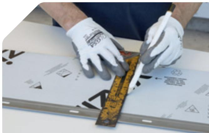
La table de sciage doit être parfaitement stable pour assurer une découpe la plus nette possible. Les bords coupés ne seront pas exposés. Le recouvrement se fera par les pièces de finitions.
