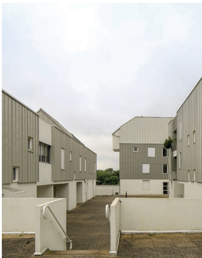
Joint debout VMZINC® - Laqué Dune, Collection Howlite - Architecte : Cabinet Rhizome - Laval - France
