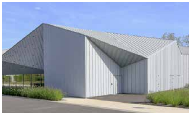
Joint debout en couverture VMZINC®, Feuilles perforées - PIGMENTO à la demande - Architecte : Vignault x Faure - Pornic - France
