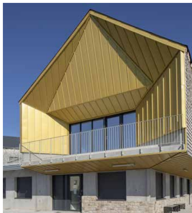
Joint debout en couverture VMZINC® - PIGMENTO à la demande - Architecte : Vignault x Faure - Crac'h - France
