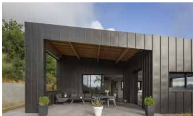
Joint debout en couverture VMZINC® - PIGMENTO à la demande - Architecte : Amélie Couffignal - Onet-le-Château - France
