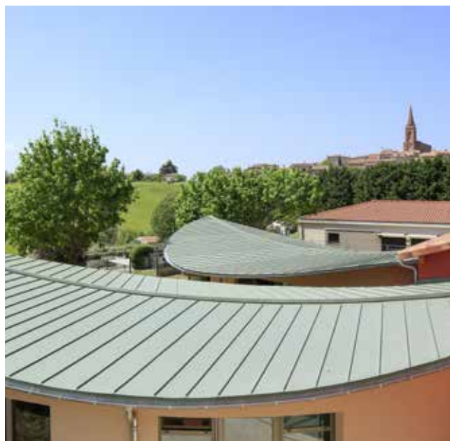
Joint debout en couverture VMZINC® - PIGMENTO® vert lichen - Architecte : Bamboo - Caraman - France
