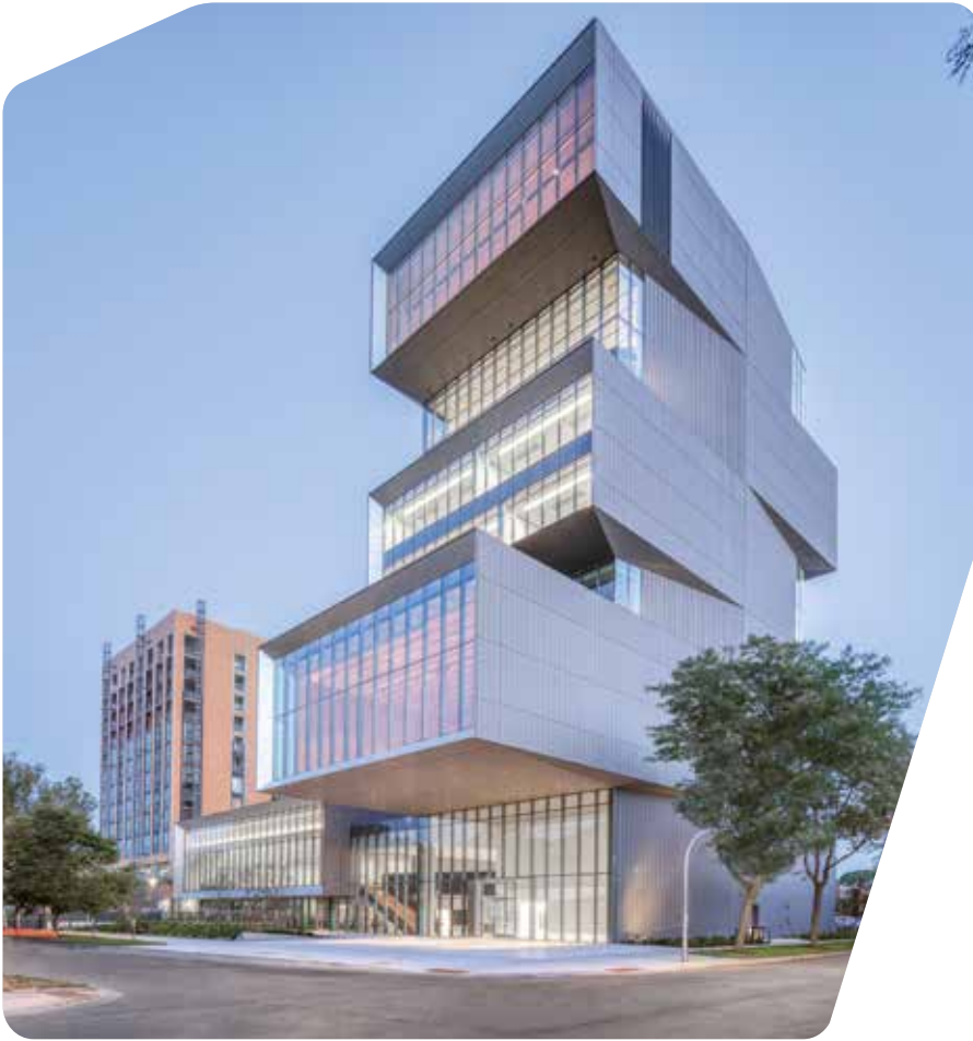
LEED : Gold • David Rubenstein forum, Architects: Diller Scofidio + Renfro • Chicago (US)
