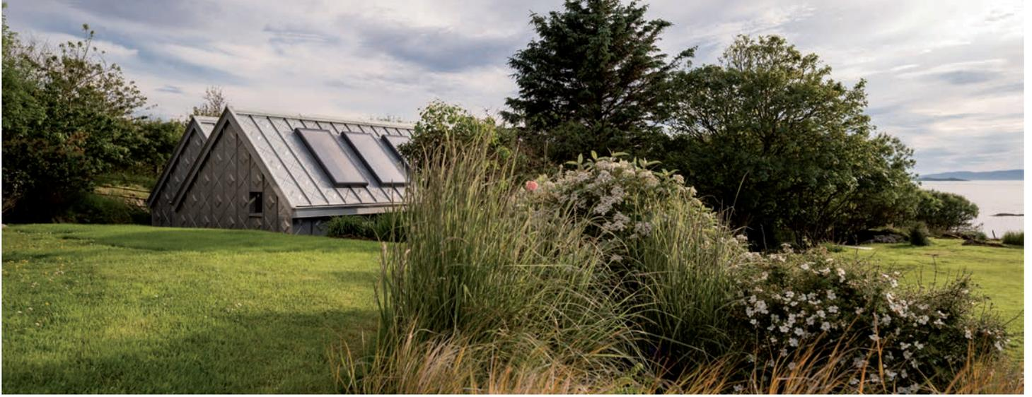
confiée à VMZINC® en raison de ses capacités à adapter ses systèmes existants aux besoins spécifiques des architectes. « Pour cet atelier, avec une toiture à double pente, le système traditionnel de mise en œuvre à joint debout a été retenu » explique Sammy Baron, Customer Support Manager Ornaments chez VMZINC®. « C'est à la fois un système
