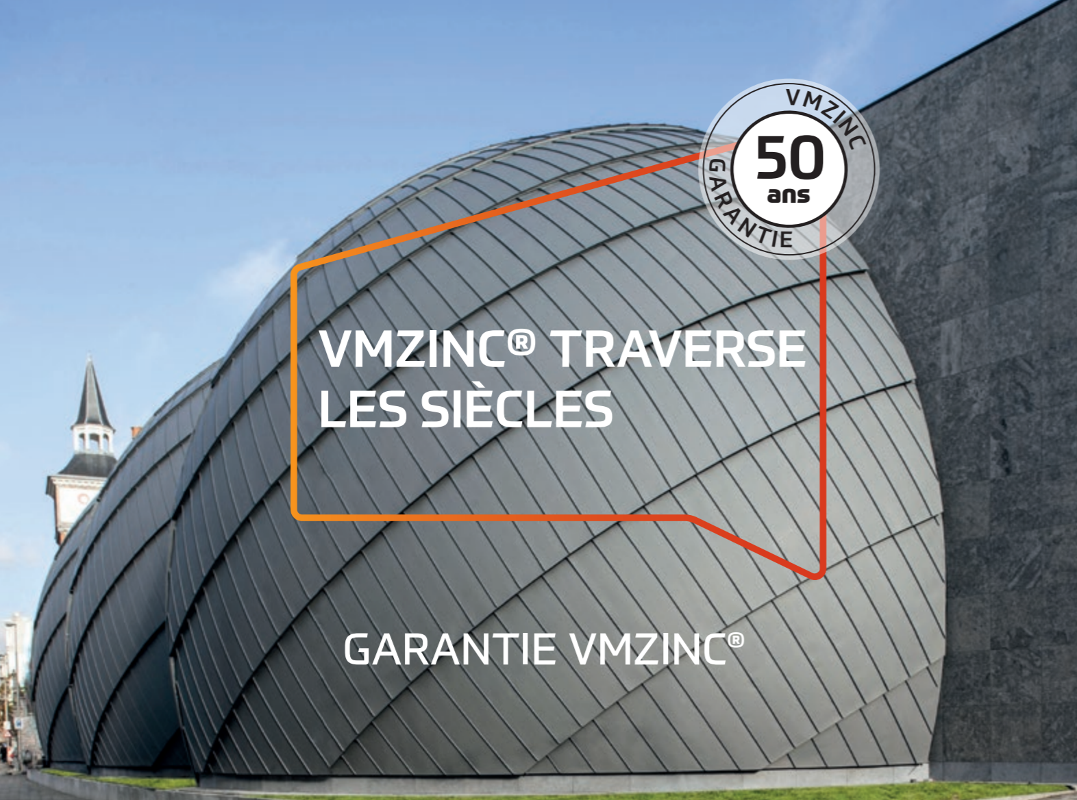
École Benedictus, Gand (Belgique) - Architecte : Danny Vandewalle, Corijn et Leyman
