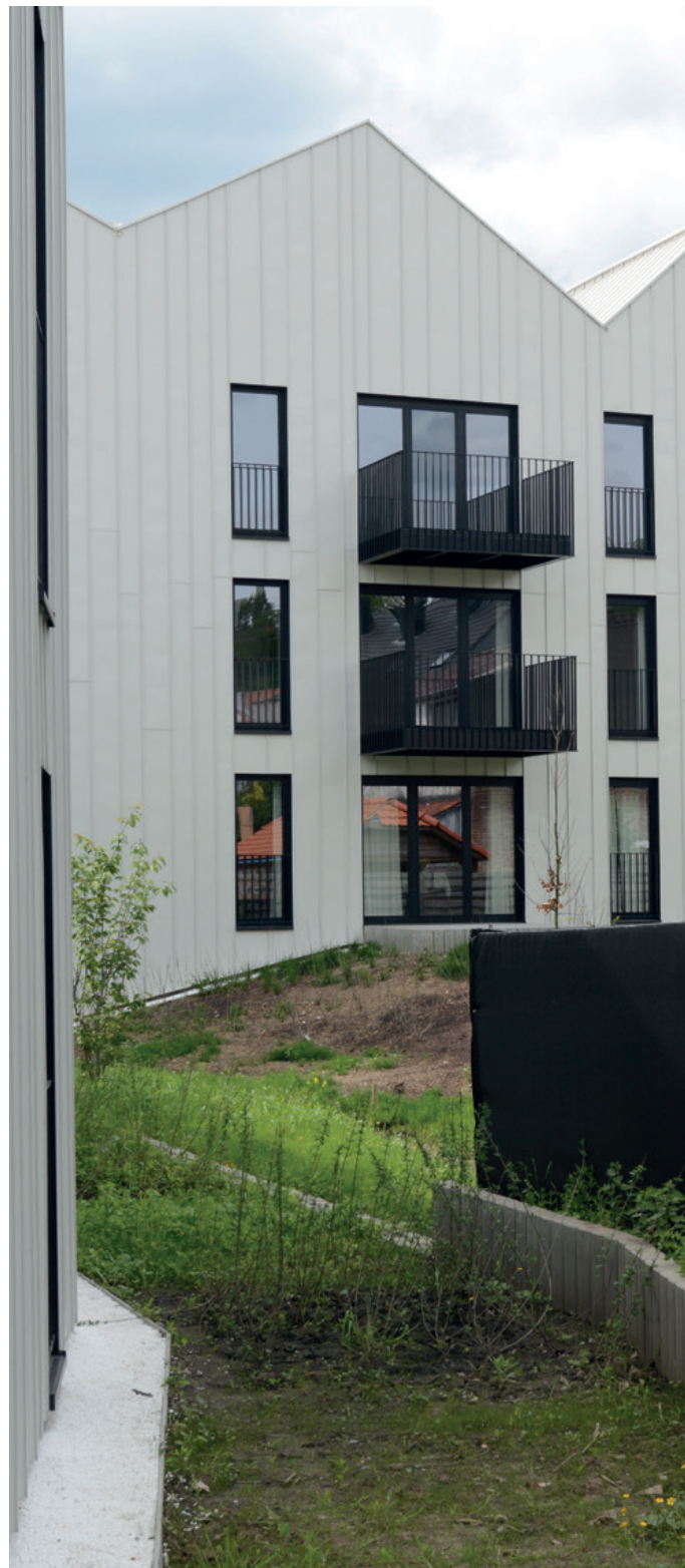
Staande naad VMZINC, gelakt zink wit Architect : BOGDAN & VAN BROECK Den Travoo – Hoeilaart – Belgium
