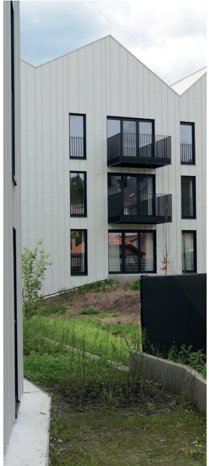
Staande naad VMZINC, gelakt zink wit Architect : BOGDAN & VAN BROECK Den Travoo – Hoeilaart – Belgium
