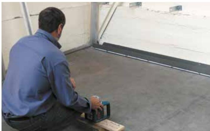
**Aplomb** La longueur des équerres de fixation est déterminée par l'épaisseur de l'isolant. La profondeur de l'ossature assurera la lame d'air minimum nécessaire à l'aération de la paroi. Les équerres se fixent au gros œuvre par chevillage.
