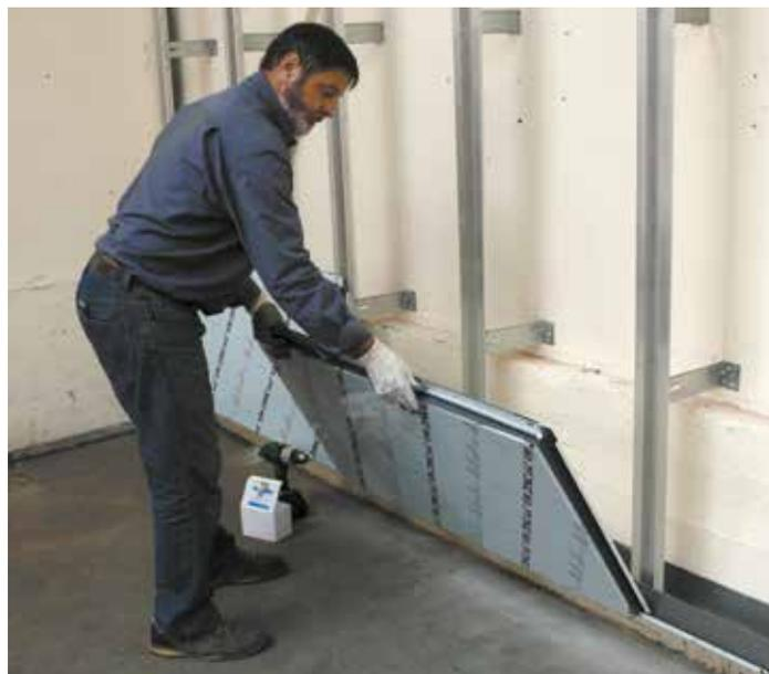
Les cassettes MOZAIK® se fixent sur le profilé d'ossature avec des vis autoperceuses ou rivets.
