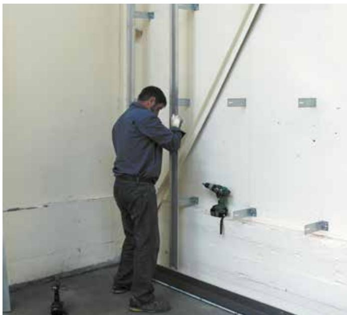
L'ossature en profilés aluminium Omega ou "T" est fixée verticalement ou horizontalement sur les équerres. On apportera un soin tout particulier à la précision de l'alignement de l'ossature pour assurer la bonne planéité de la façade.
