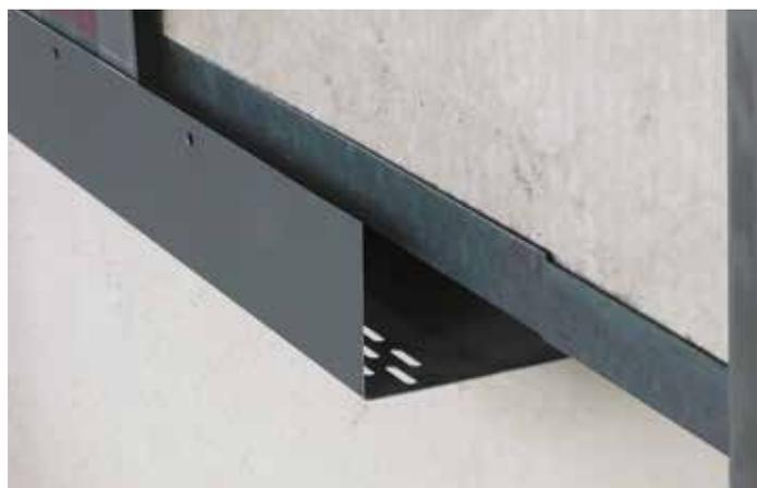
Le pied de bardage du système MOZAIK® ménage une section d'entrée d'air minimale de 100 cm<sup>2</sup> par mètre linéaire.
