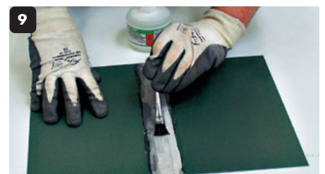
9 Appliquez localement du Zinn 7. Assemblez les 2 feuilles de zinc conformément au schéma des p 6 - 7.
