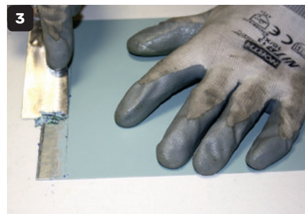
3 Enlèvement de la laque par décapage chimique.
