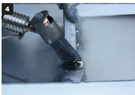
4 Réalisation d'un étamage (si épaisseur > 0,8 mm). Ensuite redépose du métal d'apport (si épaisseur > 0,8 mm).
