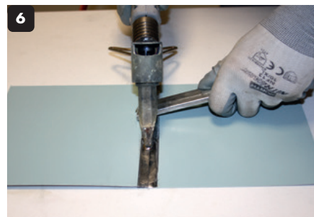
6 Appliquez du Zinn 7 sur la longueur de la soudure. Soudo-brasage des éléments.
