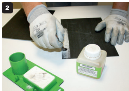
2 Premier décapage au Deca VMZINC.
