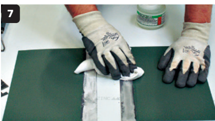
7 Enlèvement de la couche de prépatinage avec un chiffon sec.
