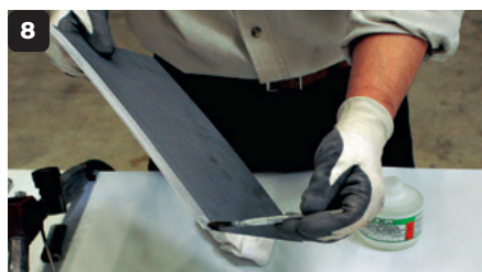
8 Décapage de la partie inférieure de l'élément supérieur (Deca VMZINC).
