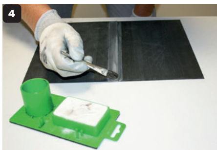
4 Utilisez du Zinn 7 localement. Assemblez les 2 feuilles de zinc conformément au schéma des p 6 - 7.
