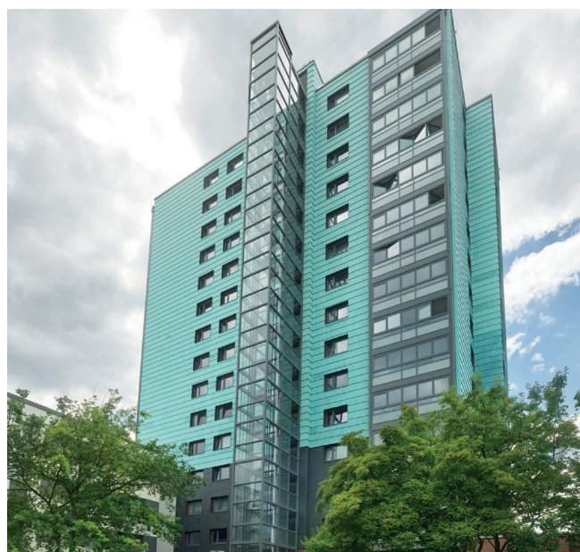
Wohnhaussanierung (Deutschland) - Firma: Rold Kleinfeld GmbH - Oberfläche: Nordic Blue Living 3
