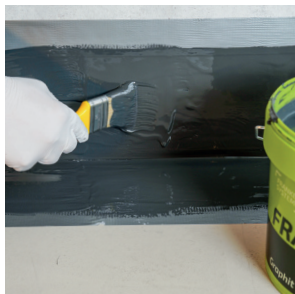
Aanbrengen van de 1e laag ofwel met kwast ...
